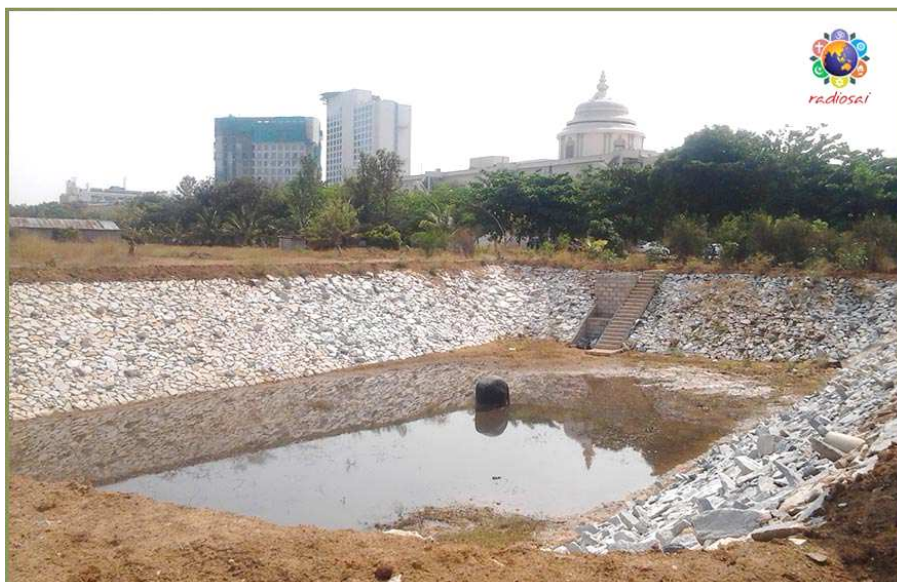
Le bassin de récupération des eaux de pluies au SSSIHMS-WF
