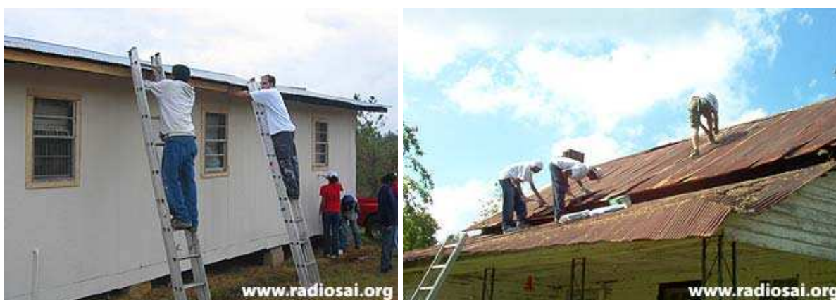
La jeunesse Sai réparant des maisons, immédiatement après la catastrophe Katrina
